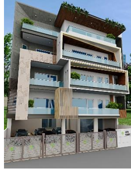
D-1591, ANSAL ESENCIA SEC-67, GURGAON 580 SQYD. ONGOING
